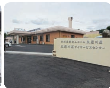
正門・門扉の改修
